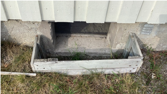
Luke for innsyn til kryperom under opprinnelig del.
