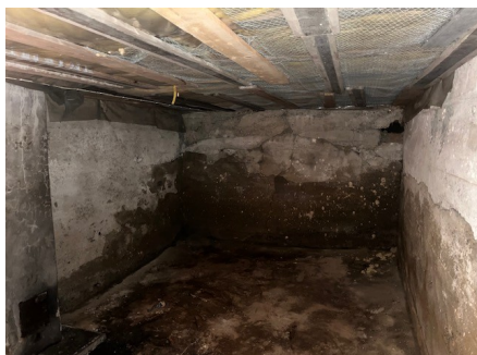
Fuktinnhold i treverk i kjeller på ca. 24 vektprosent.
