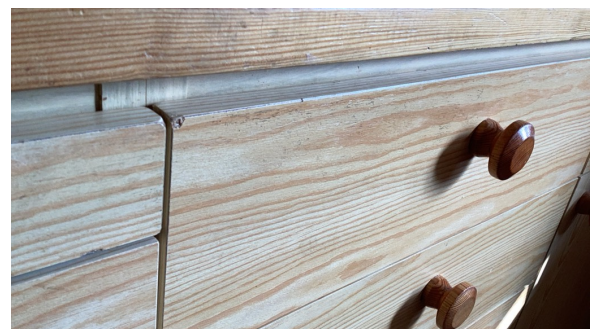
Eksempel på slitasje.
