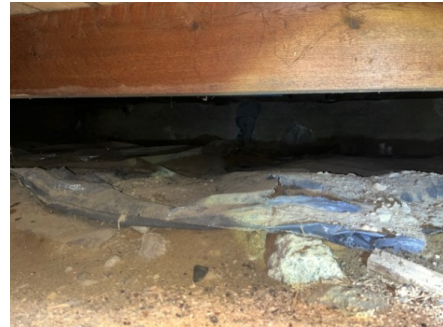
Kryperom under gang
