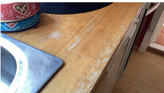
Eksempel på slitasje.
