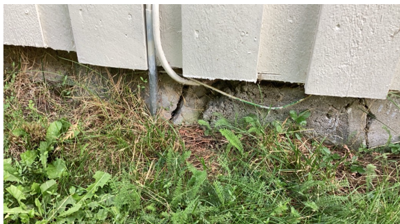
Eksempel på utvendig sprekk.
