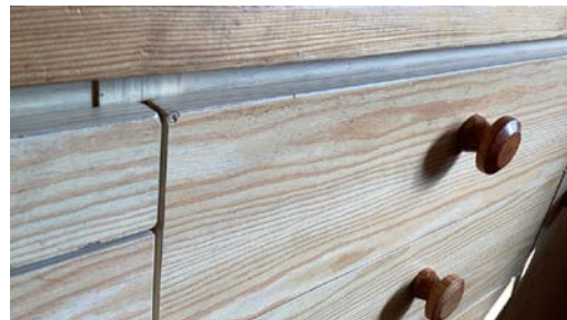
Eksempel på slitasje.
