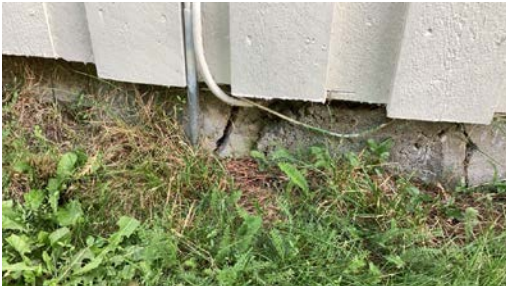
Eksempel på utvendig sprekk.
