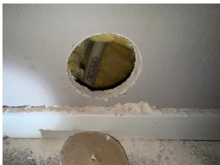
Hulltaking i tilstøtende entré
