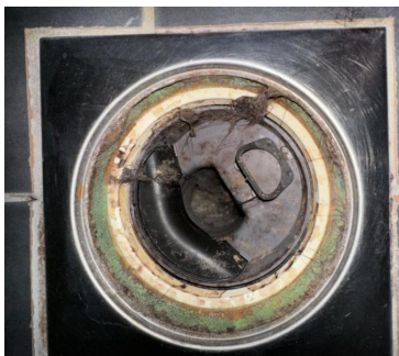
Plastsluk med klemring og synlig membran/mansjett
