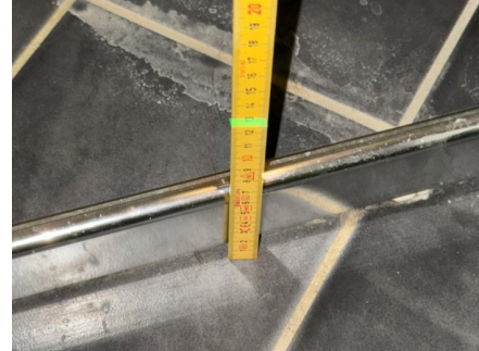
Fallforhold ca. 125 mm overkant gulv ved dusjsone
