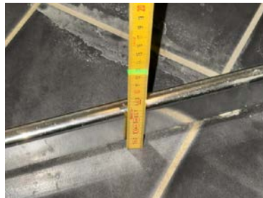
Fallforhold ca. 125 mm overkant gulv ved dusjsone
