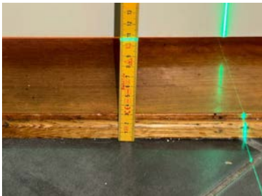
Fallforhold ca. 106 mm overkant gulv ved terskel
