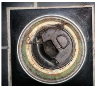
Plastsluk med klemring og synlig membran/mansjett
