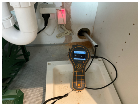
Hulltaking i benkeskap 10.02.2026.
