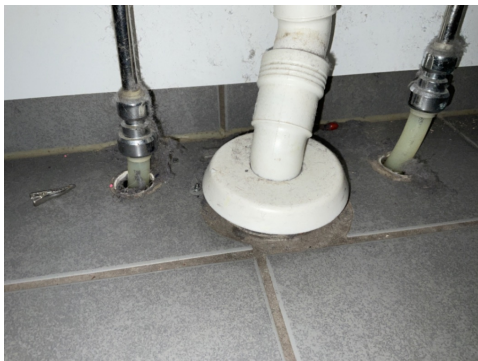
Rør gjennomføringen i gulvet
