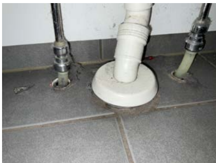
Rør gjennomføringen i gulvet
