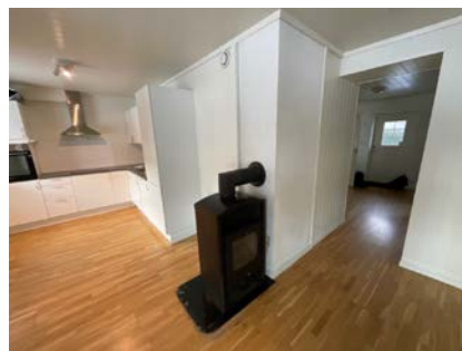
Vedovn og pipe
