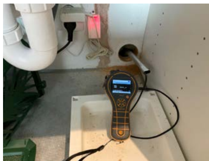
Hulltaking i benkeskap 10.02.2026.
