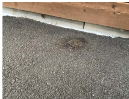
Isolerte elementer som grunnmur
