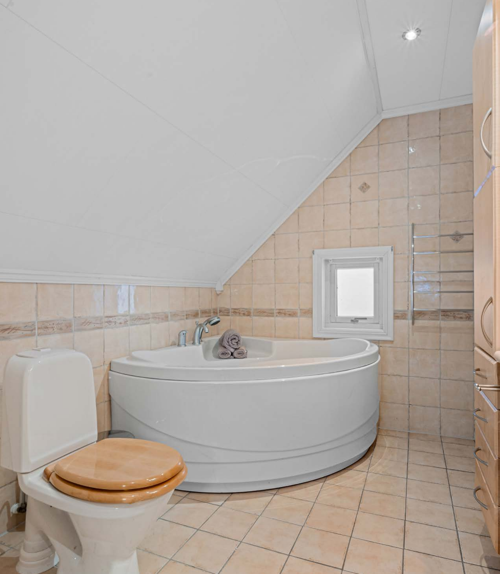
Vannbåren varme i gulv.
