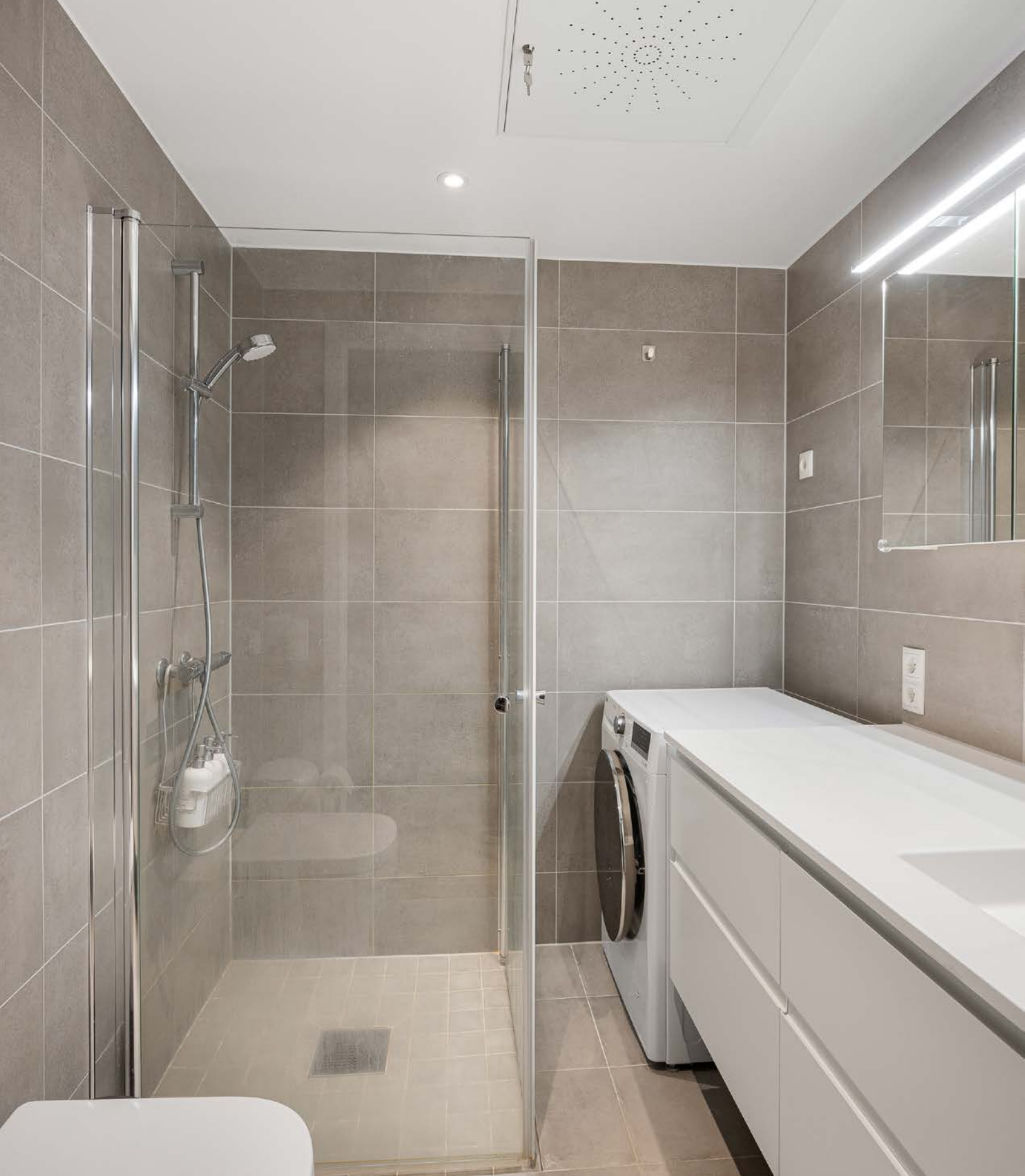
Badet har vannbåren gulvvarme.
