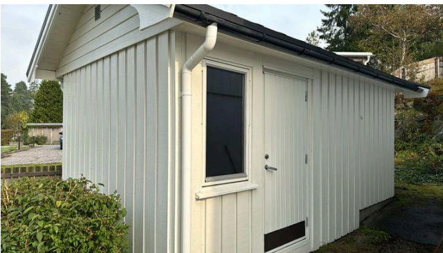
Oversiktsbilde av frittstående bod
