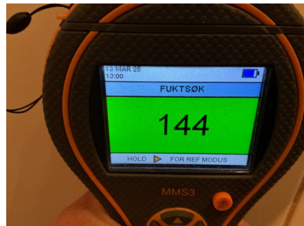
Det ble foretatt stikkprøvekontroll med Protimeter MMS3. Målingene viste ingen utslag utenfor normale verdier. Målingene gir kun en indikasjon og må ikke oppfattes som en garanti for badetrommet.
