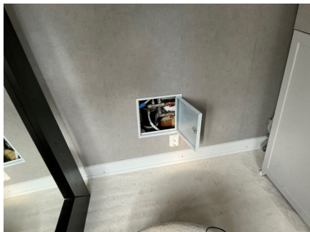
Målinger er foretatt fra inspeksjonsluke inne på soverom.
