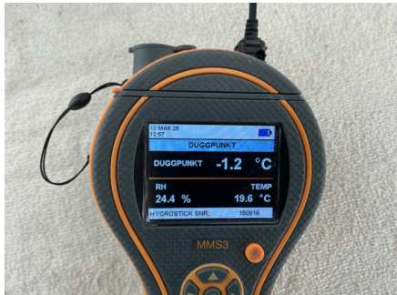
Måling relativ luftfuktighet. Målinger er foretatt fra inspeksjonsluke inne på soverom uten å påvise unormale forhold.
