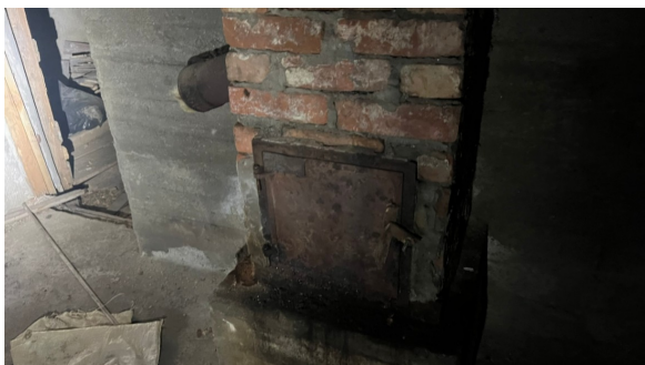
Sotluken i kjelleren.
