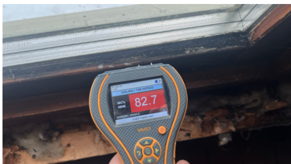
Eksempel på fuktmåling i vidu med høt fuktighet.
