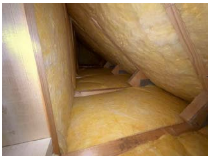
Stedvis synlig konstruksjon bak knevegger.
