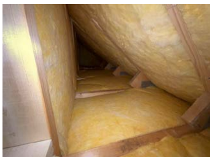
Stedvis synlig konstruksjon bak knevegger.
