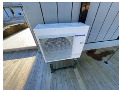
Varmepumpe, utvendig aggregat.
