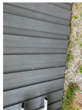
Værslitt/oppsprukket kledning.
