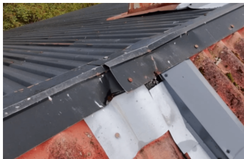
Utettheter i beslagløsningen.
