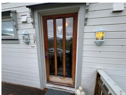
Utett mellom dørblad og karm.
