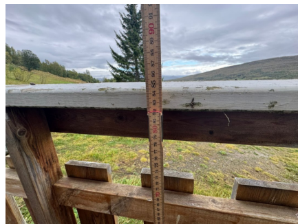
Høyden på rekkeverket.
