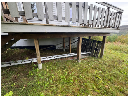
Utvendig fuksikring er avsluttet midt på veggen.
