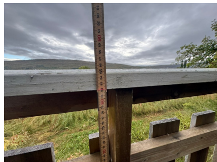
Rekkverkshøyden.
