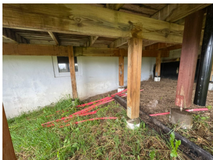
takrennenedløpet fra altaen er avsluttet ved søylefundament.
