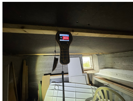
Fuktmåling i lekter i taket.
