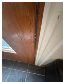
Utett mellom dørblad og karm.
