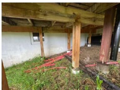
takrennenedløpet fra altaen er avsluttet ved søylefundament.
