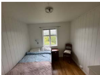
Eksempel på rom som ikke har ventilering utover åpning av vinduet.
