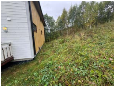
Terrengtet har fall mot boligen.
