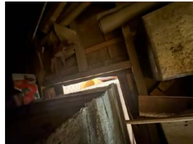
Åpninger rundt pipen.
