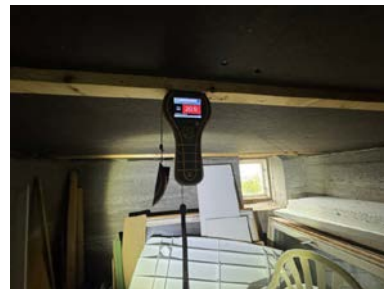
Fuktmåling i lekter i taket.
