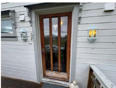
Utett mellom dørblad og karm.
