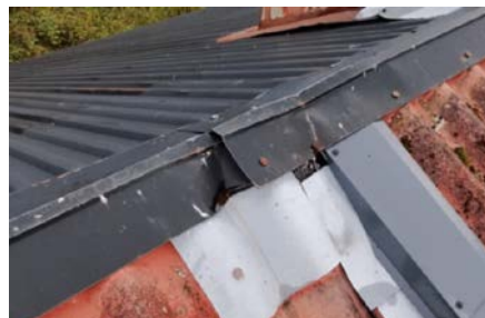
Utettheter i beslagløsningen.
