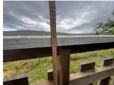
Rekkverkshøyden.
