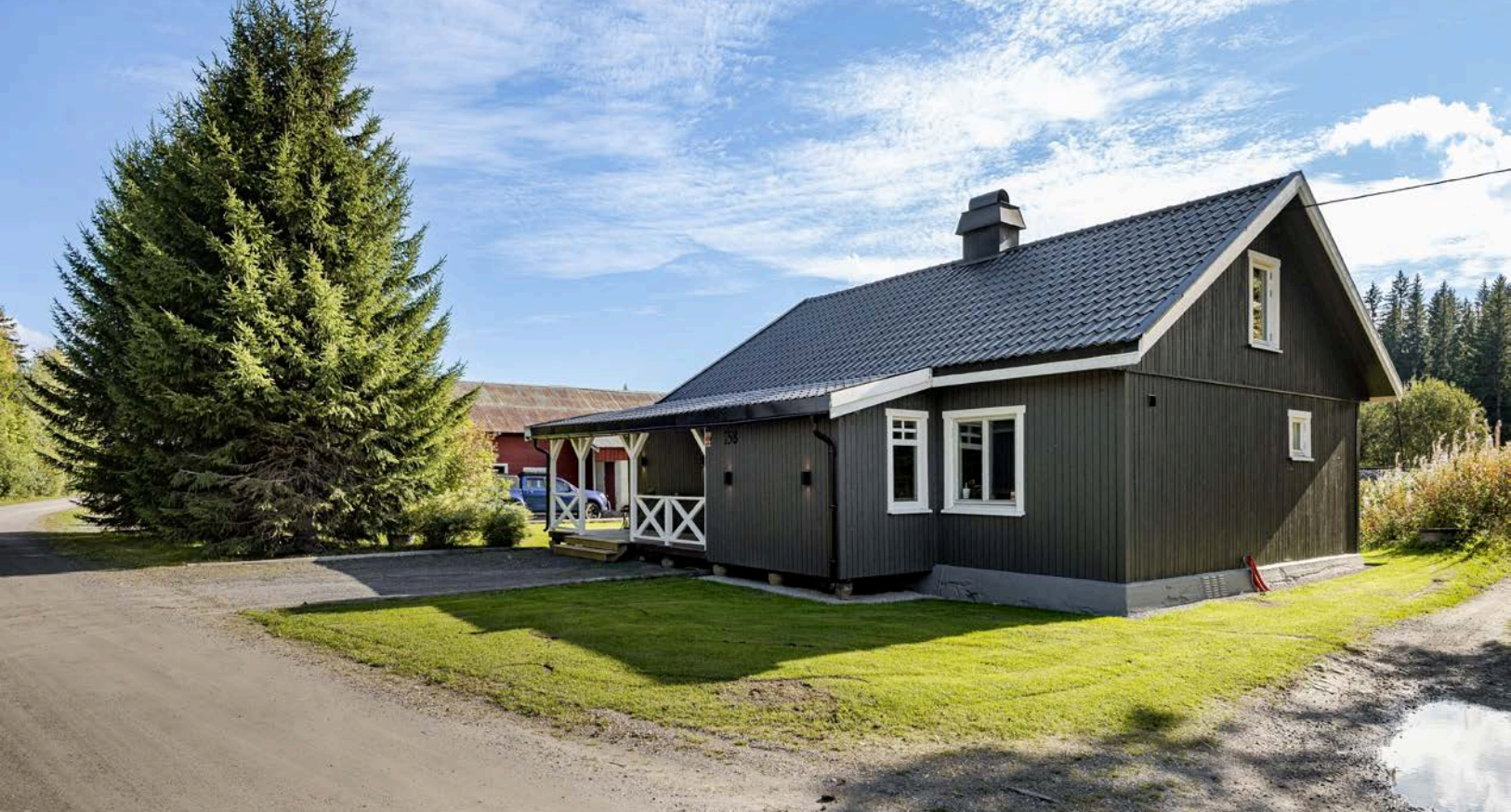
Boligen har stående bordkledning og malt fasade, med nyere takteking fra 2019.
