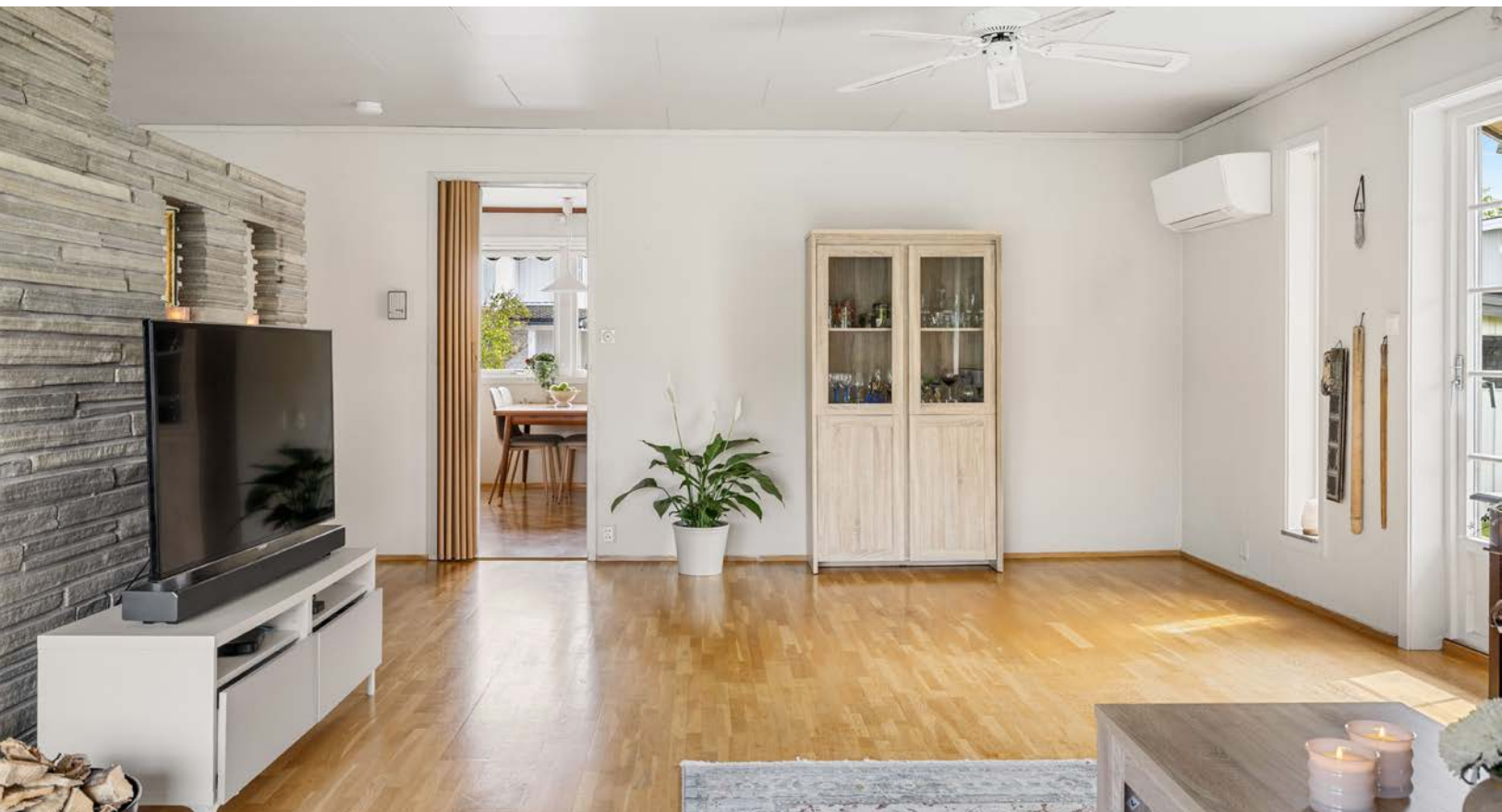
Det er også montert luft-til-luft varmepumpe fra 2020/21 som sørger for en god og jevn varme på vinterstid.
