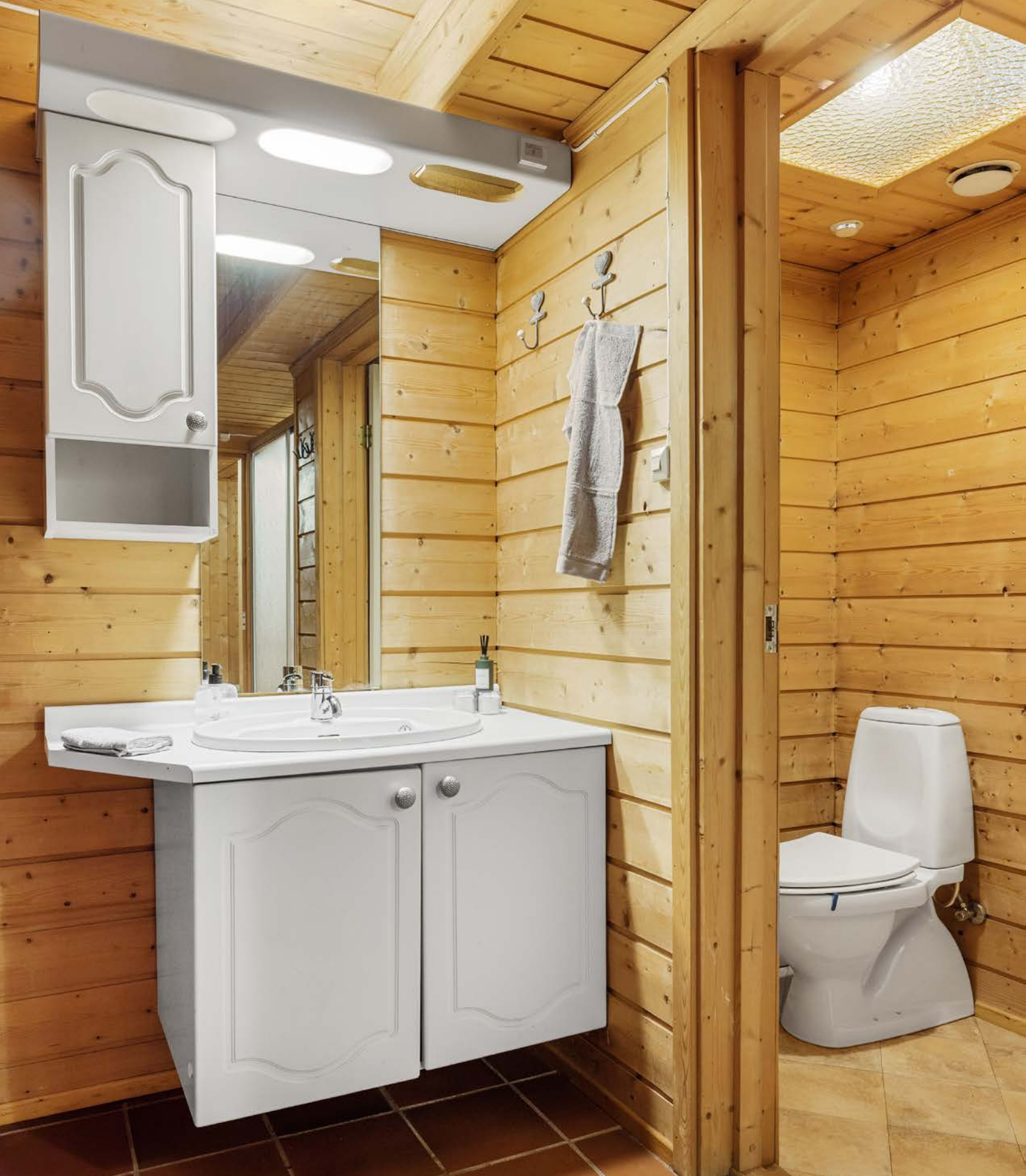
Eldre baderom i kjeller med behov for renovering. Baderommet har adkomst til toalettrom, badstue og teknisk rom med sluk.
