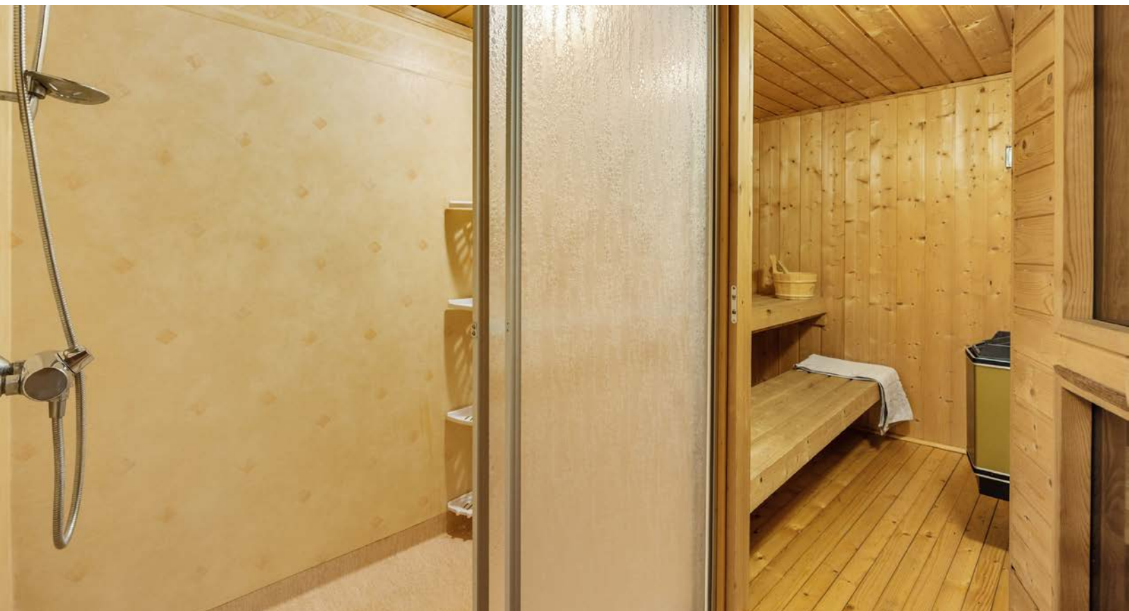
Dusjnise med skyvedør, belegg på gulv, våtromsbelegg på vegger og avtrekksventil i taket.
