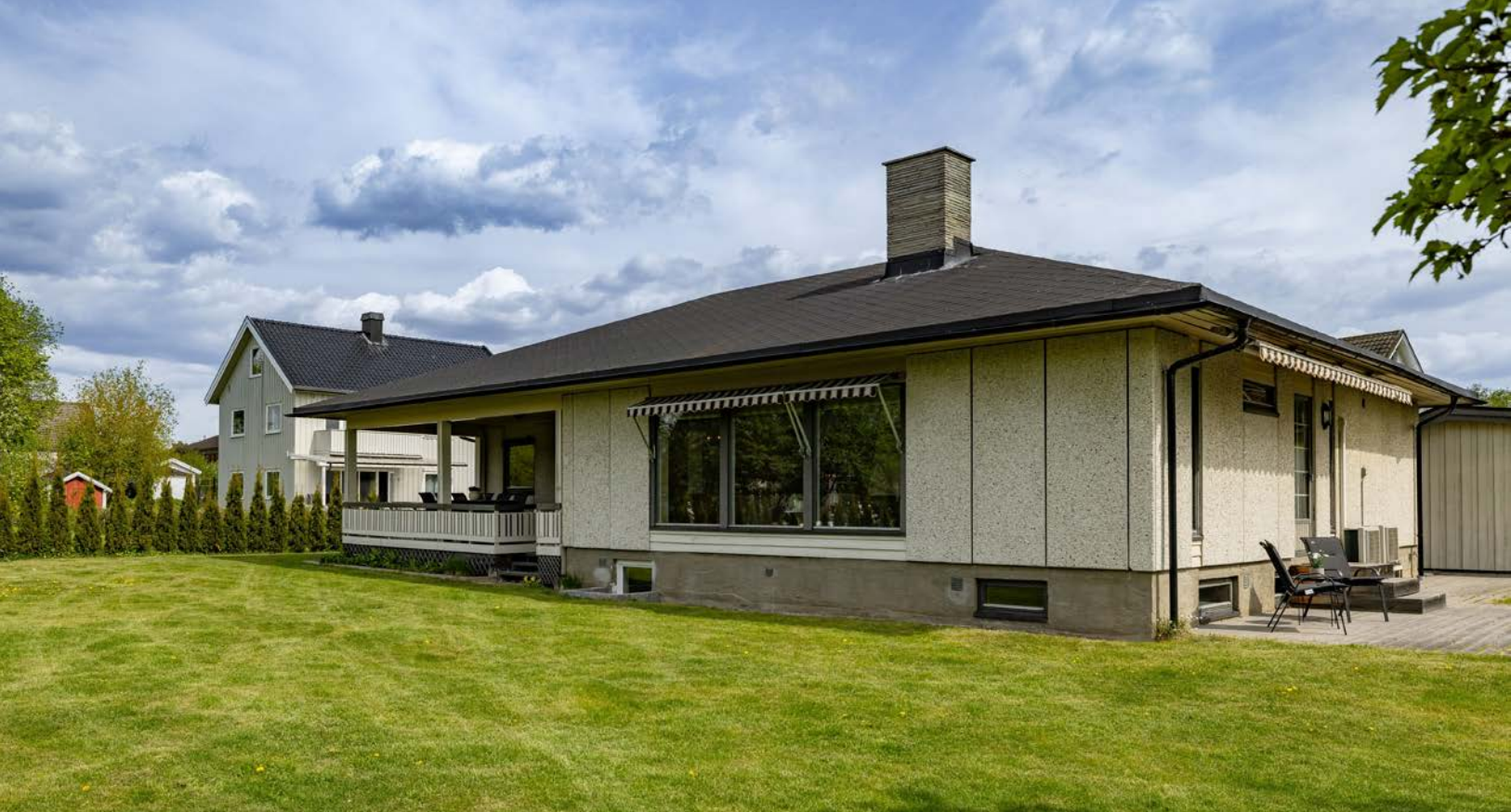
Boligen ble oppgradert i 2007 med ny takteking, nye takrenner og nedløp.
