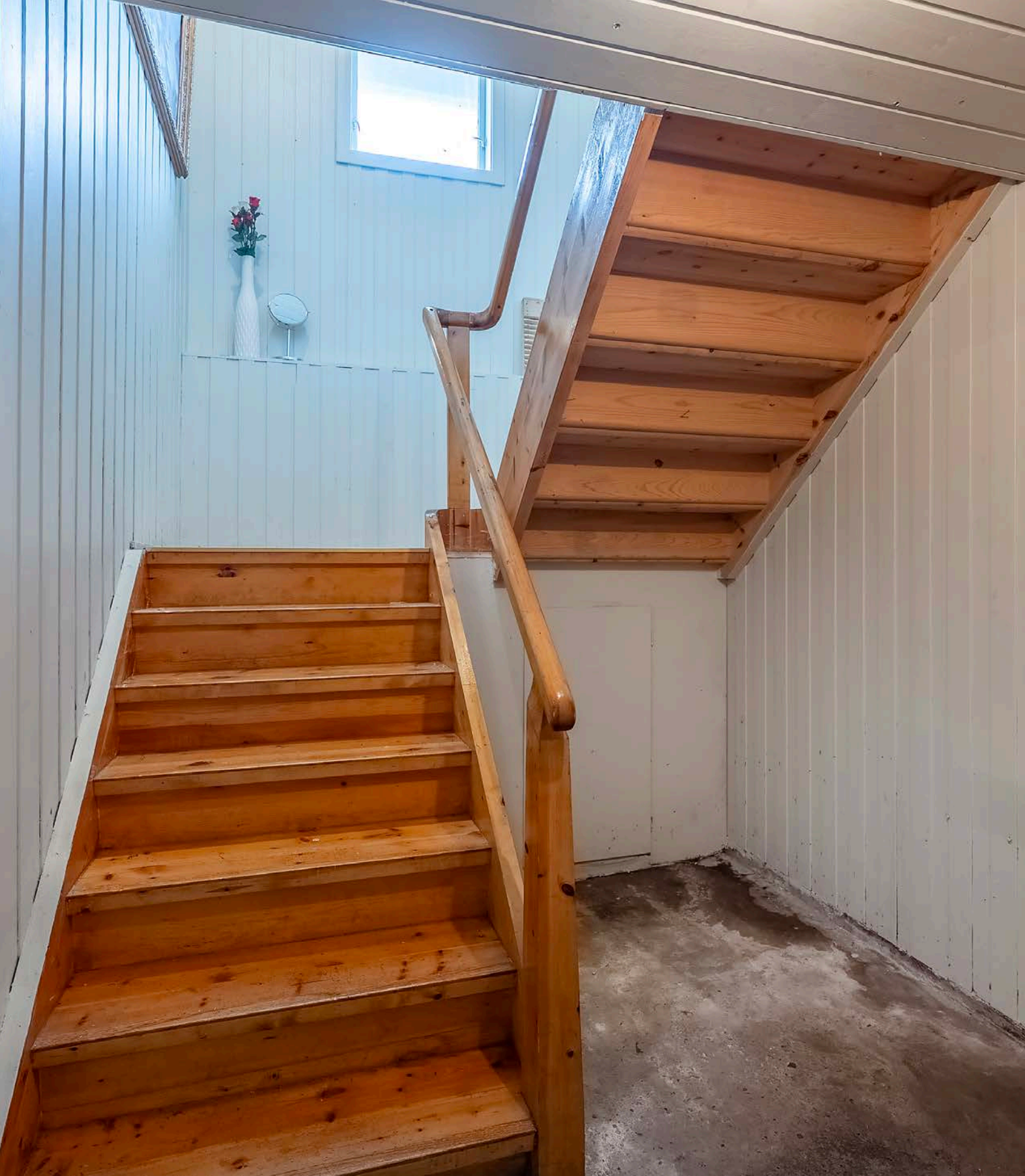
Nedgang til kjeller har u-trapp med repos Etasjen består for øvrig av vaskekjeller og fire boder, hvorav en har egen inngang
