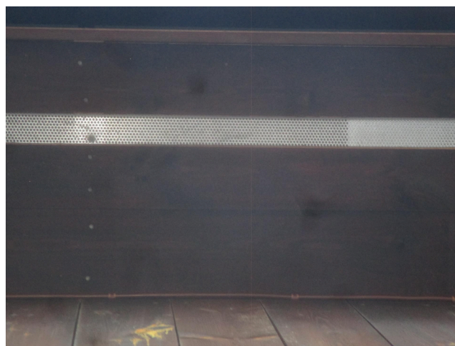
Luftespalter i gesimsen.
