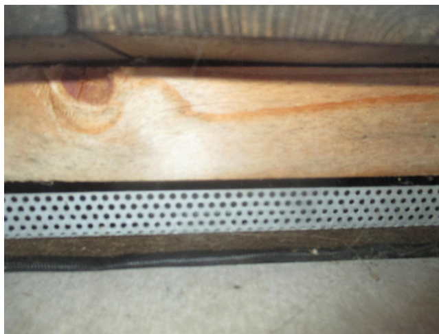
Bra med lufting og museband er montert.
