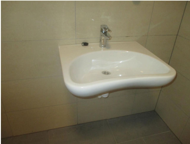
Fliser gulv og vegger med en enkel servant.
