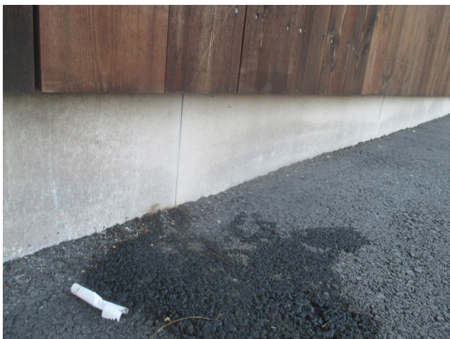
Deler av isolert ringmur.
