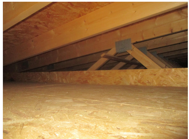
Deler av takkonstruksjonen.
