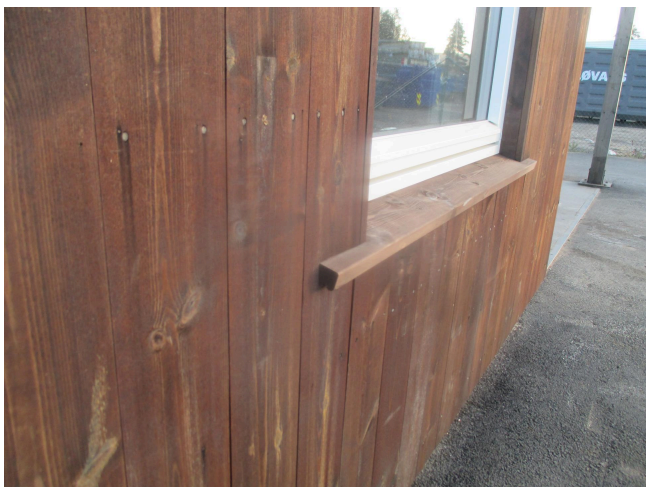
Deler av kledningen med tilhørende belistninger.
