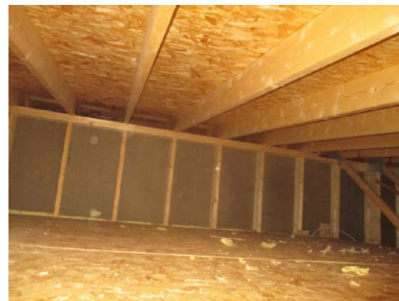
Kaldtloft over lagerrom i andre etasje.
