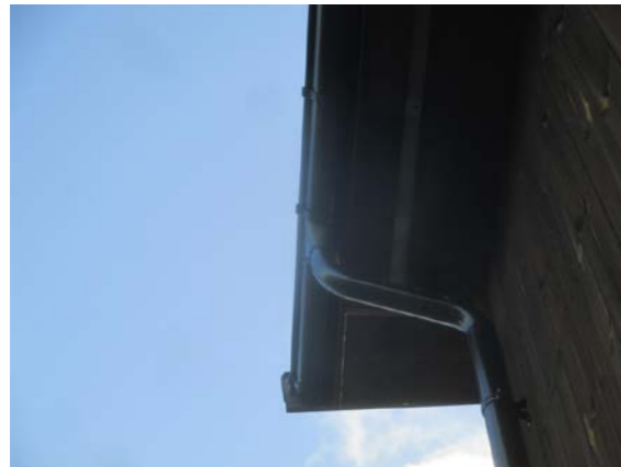
Takrenner og nedløp av stål.
