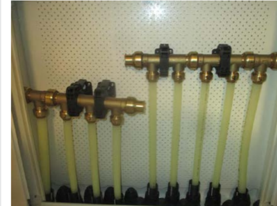
Fordelerskap for rør i rør system.
