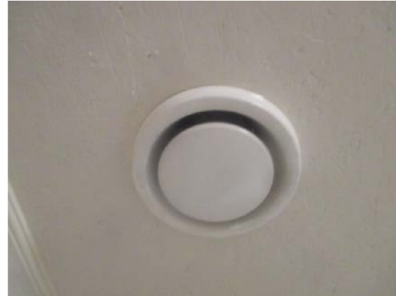
Avtrekk i himling for ventilasjon av rommet.
