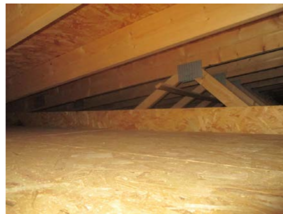
Deler av takkonstruksjonen.
