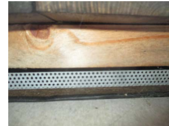
Bra med lufting og museband er montert.
