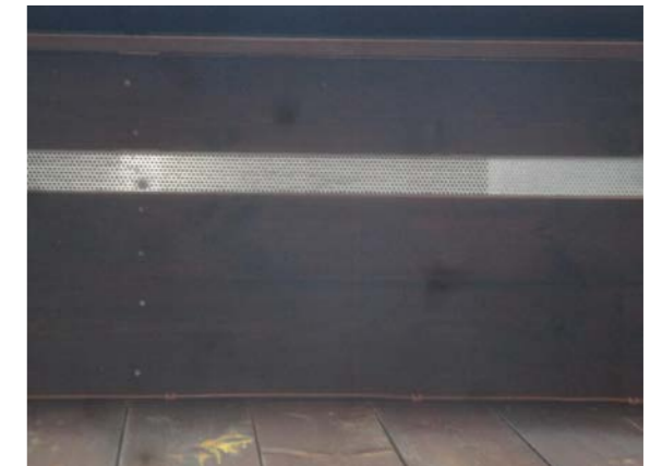
Luftespalter i gesimsen.
