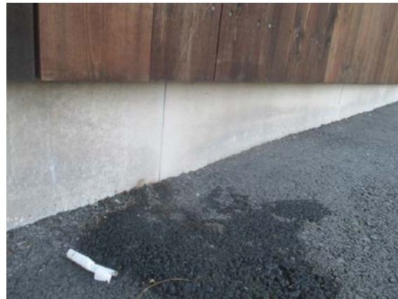
Deler av isolert ringmur.
