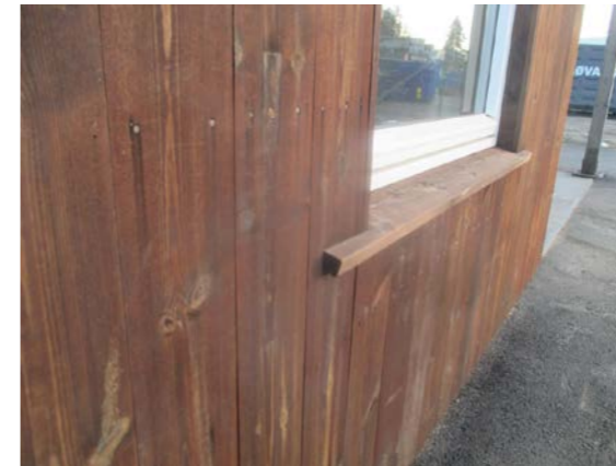
Deler av kledningen med tilhørende belistninger.
