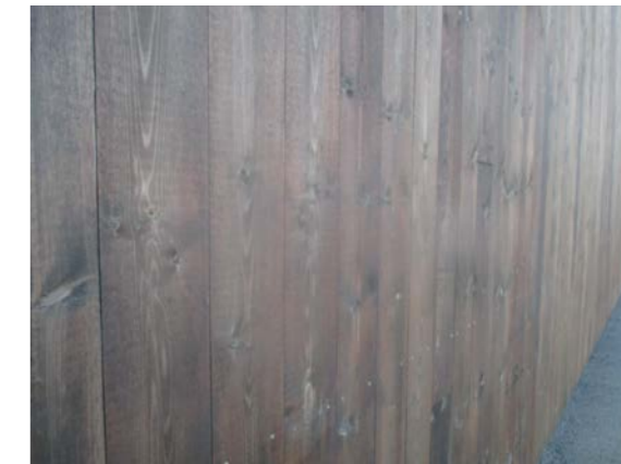
Deler av ene fasaden.
