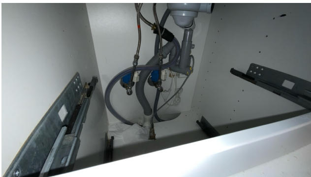
Besiktigelse av røropplegg.
