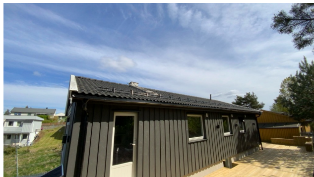
Besiktigelse av taktekte.
