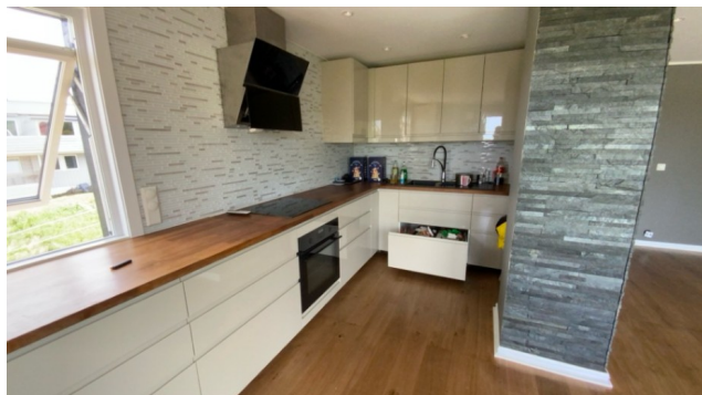
Pipeløp/pipevanger er kledd inn på alle sider.
