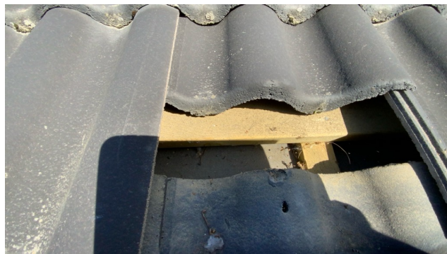
Kontroll av undertak.
