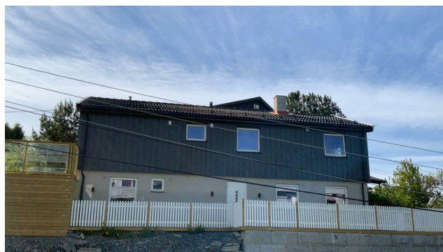
Besiktigelse av taktekte.
