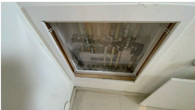
Besiktigelse av røropplegg.
