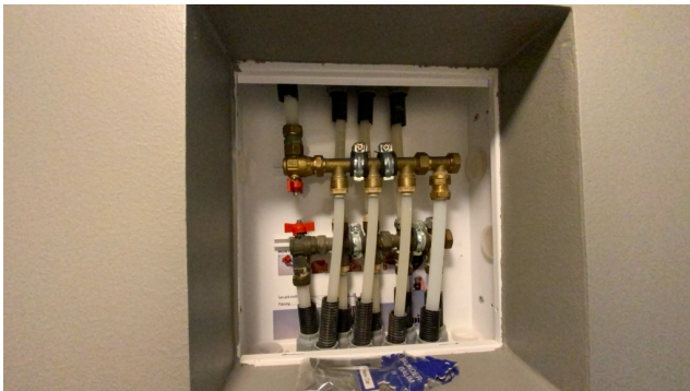
Besiktigelse av røropplegg.
