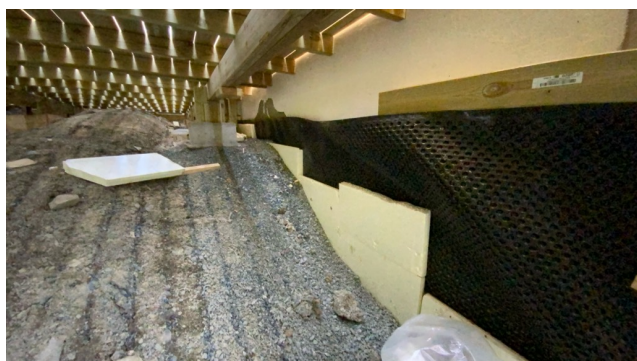
Kontroll av drenering/fuktsikring.
