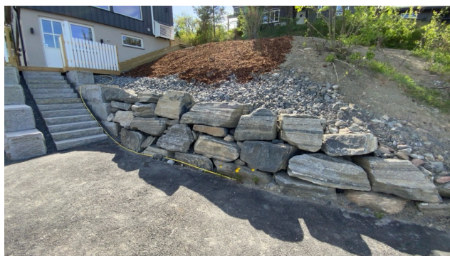
Besiktigelse av støttemur.
