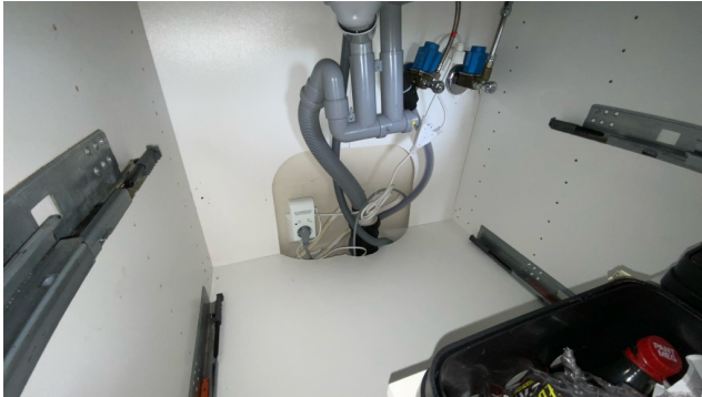
Besiktigelse av røropplegg.
