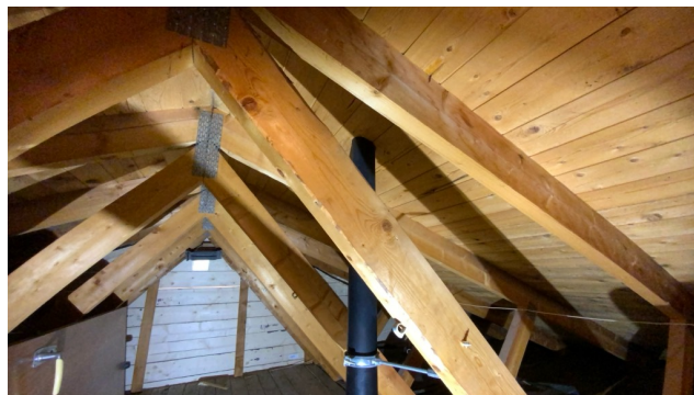
Kontroll rundt rørgjennomføringer.
