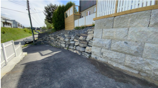
Besiktigelse av støttemur.
