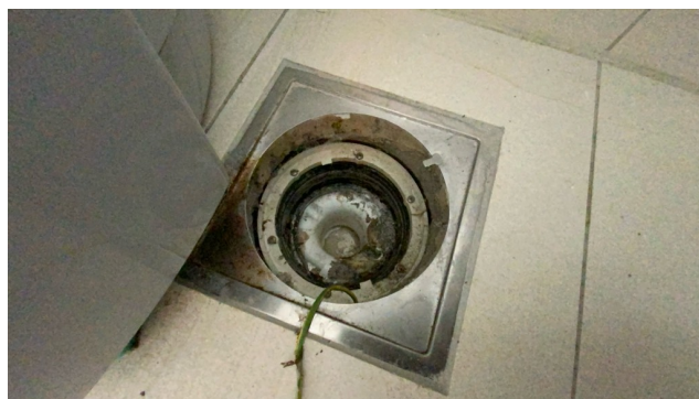
Kontroll av sluk.
