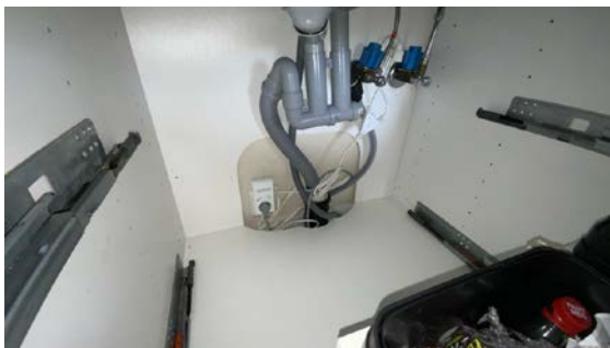
Besiktigelse av røropplegg.
