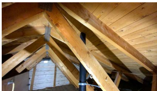
Kontroll rundt rørgjennomføringer.
