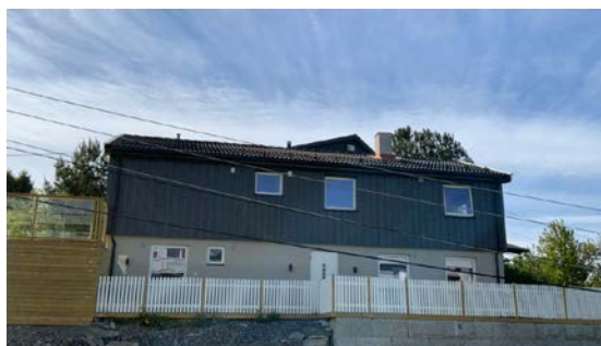
Besiktigelse av taktekk.
