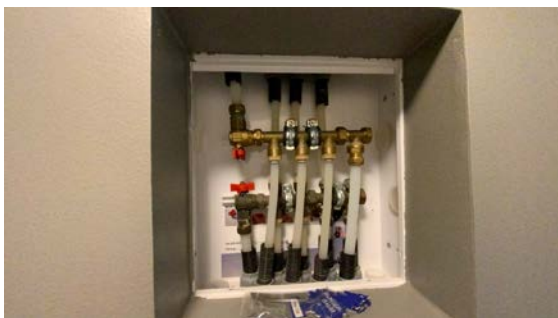
Besiktigelse av røropplegg.
