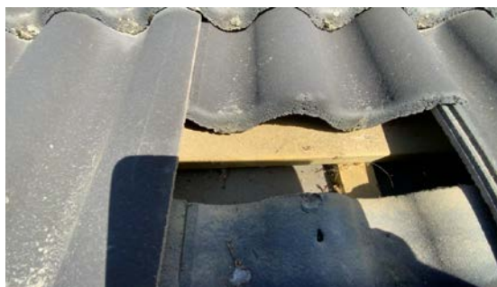
Kontroll av undertak.
