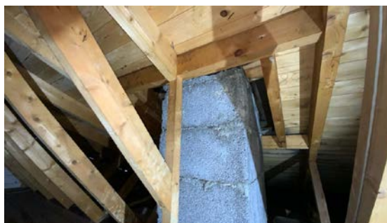
Kontroll rundt pipeløp.
