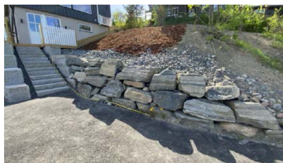
Besiktigelse av støttemur.
