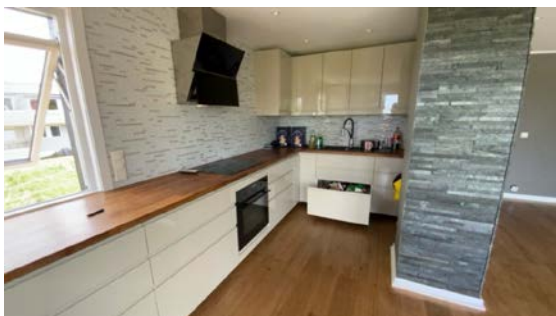
Pipeløp/pipevanger er kledd inn på alle sider.
