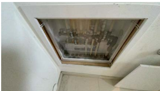
Besiktigelse av røropplegg.
