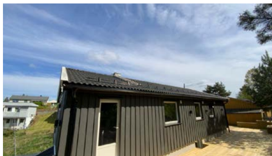
Besiktigelse av taktekk.
