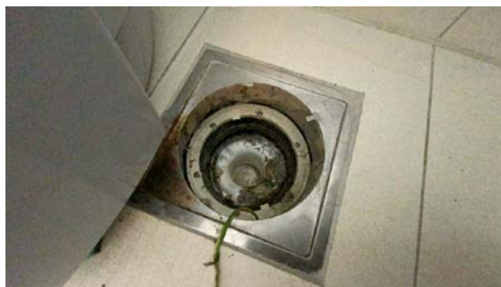
Kontroll av sluk.
