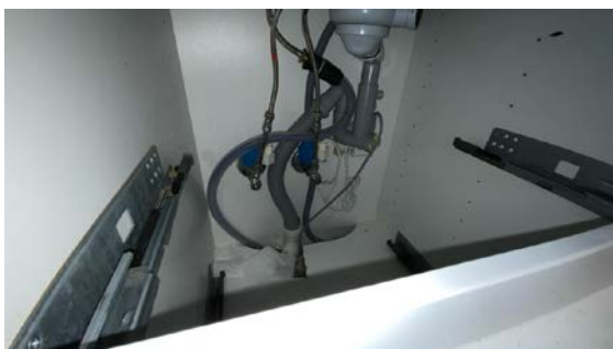
Besiktigelse av røropplegg.
