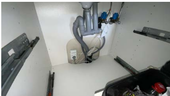
Besiktigelse av røropplegg.
