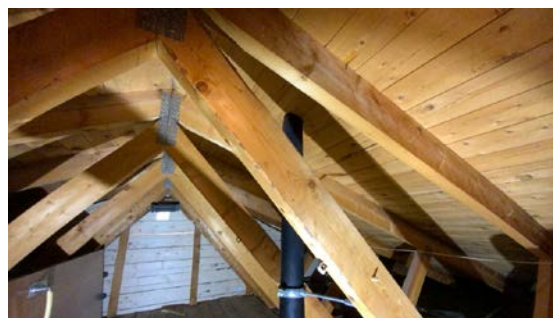
Kontroll rundt rørgjennomføringer.
