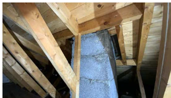
Kontroll rundt pipeløp.
