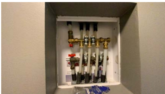
Besiktigelse av røropplegg.
