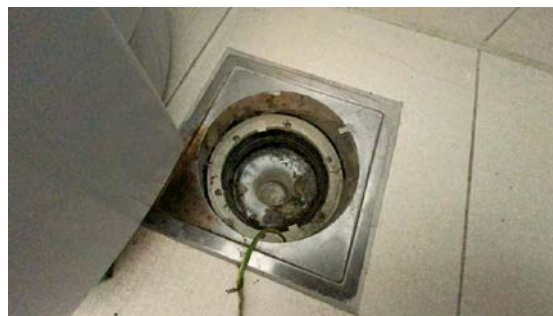
Kontroll av sluk.
