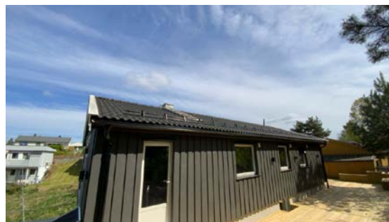
Besiktigelse av taktekke.
