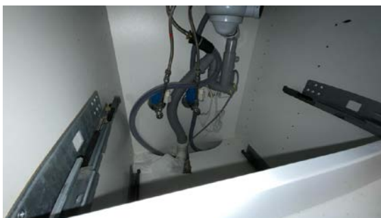
Besiktigelse av røropplegg.
