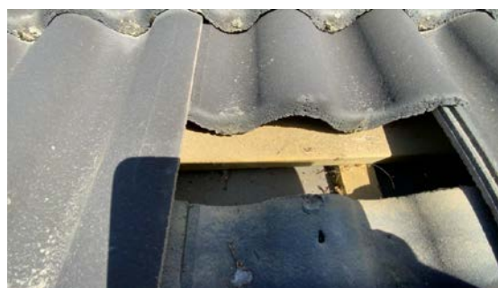
Kontroll av undertak.
