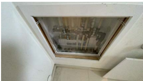
Besiktigelse av røropplegg.
