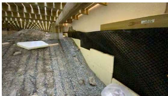
Kontroll av drenering/fuktsikring.
