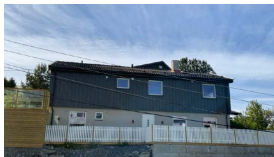
Besiktigelse av taktekke.
