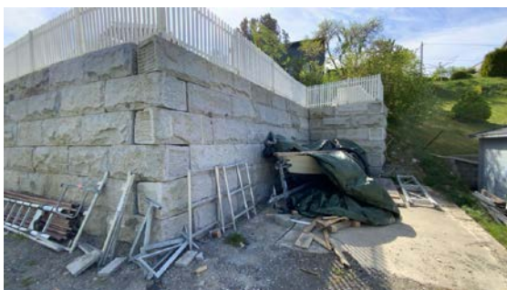
Besiktigelse av støttemur.
