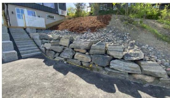
Besiktigelse av støttemur.
