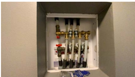
Besiktigelse av røropplegg.
