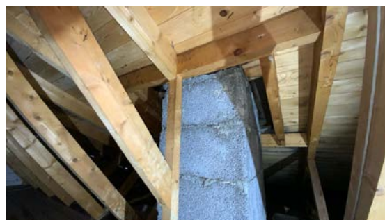
Kontroll rundt pipeløp.
