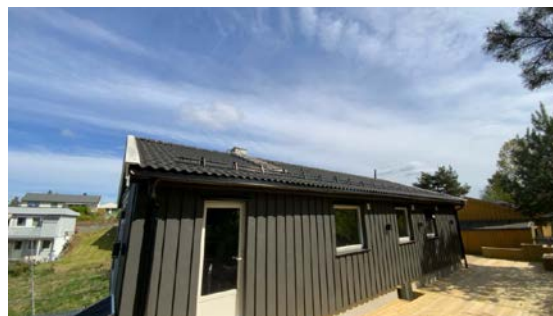
Besiktigelse av taktekke.
