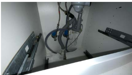
Besiktigelse av røropplegg.
