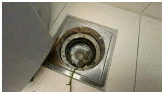
Kontroll av sluk.
