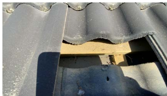
Kontroll av undertak.
