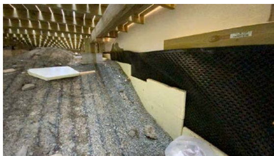
Kontroll av drenering/fuktsikring.
