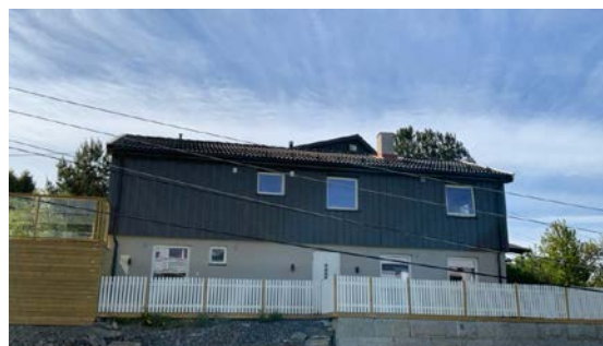
Besiktigelse av taktekke.
