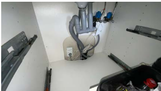
Besiktigelse av røropplegg.
