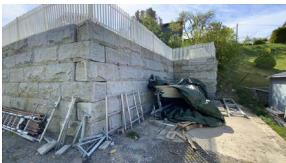
Besiktigelse av støttemur.
