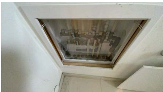
Besiktigelse av røropplegg.
