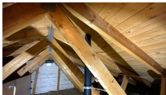
Kontroll rundt rørgjennomføringer.
