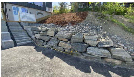
Besiktigelse av støttemur.
