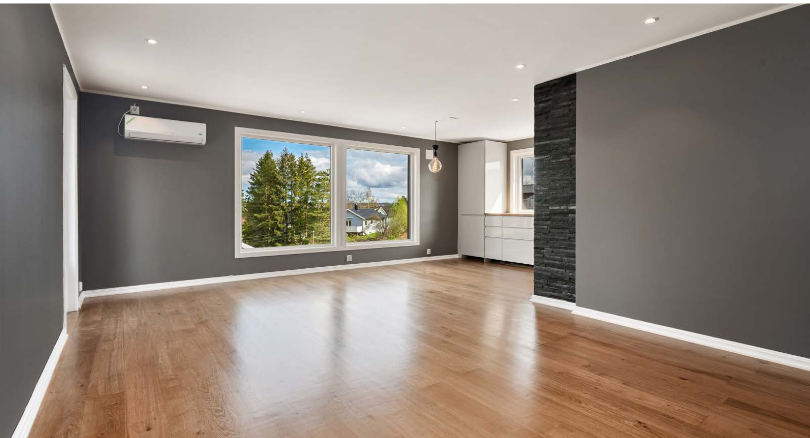
Det er montert varmepumpe.
