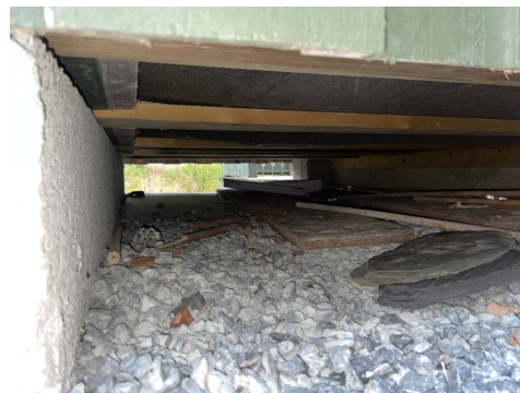
Tilbygg ut fra stue med åpent luftet kryperom.
