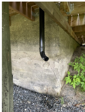
Synlig skader i overflate på mur
