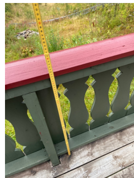
Lav høyde. Ellers synlig værslittasje/sprekker i treverk på terrassebord og rekkverk.
