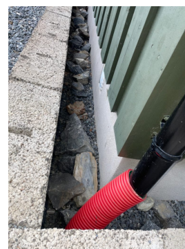
Støttemur av lettklinkerblokker.
