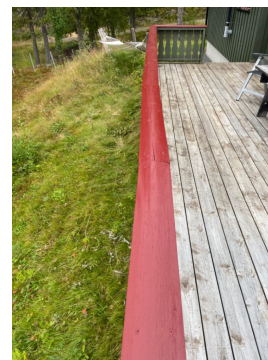
Lav høyde. Ellers synlig værslittasje/sprekker i treverk på terrassebord og rekkverk.
