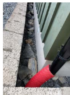
Støttemur av lettklinkerblokker.
