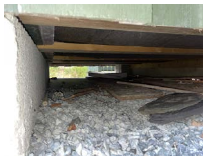
Tilbygg ut fra stue med åpent luftet kryperom.
