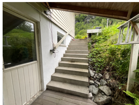
Gavlvegg slørst; betongtrapp.
