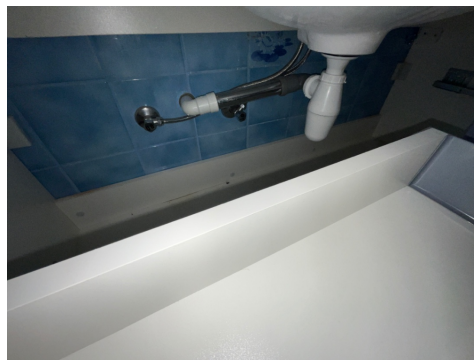
Hovedetasje: Røropplegg under håndvask, bad.
