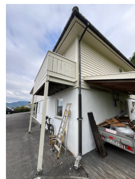
Nedløp, langsida sørvest; nedløp avsluttes på asfalt med avrenning bort fra bolig.
