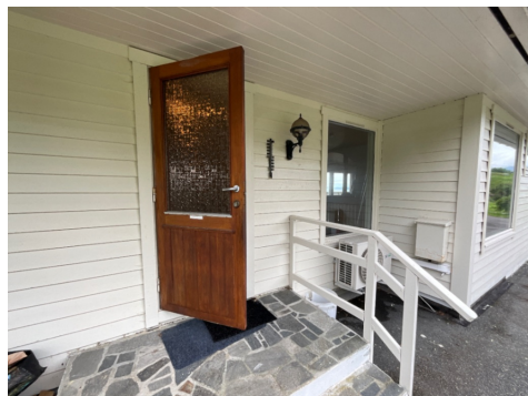
Dør med utgang fra vaskerom.
