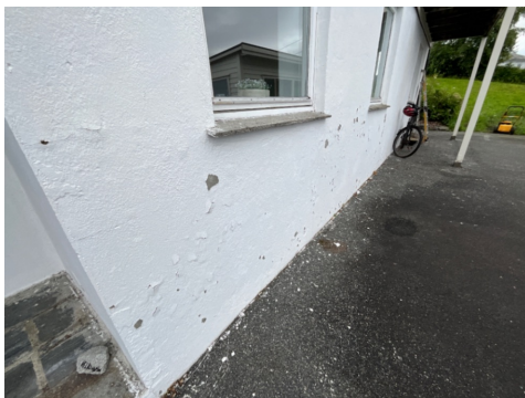
Grunnmur ved hovedinngang
