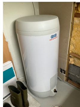
Varmtvannstank montert på vaskerom.
