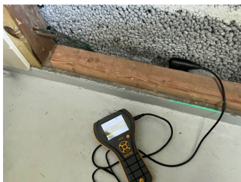
Fuktmåling i bunnsvill, vaskerom. Forhøyet fuktverdi, men ingen tegn til fukt/ råte
