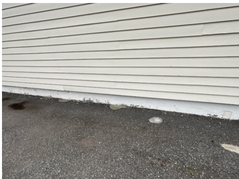
Lufteluger i vegg.
