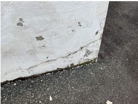
Nærbilde av grunnmur garasje under terrasse.
