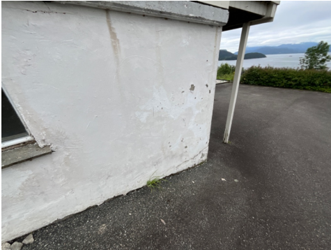
Grunnmur garasje under terrasse.
