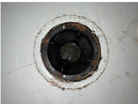
Plastsluk mot betongdekke.
