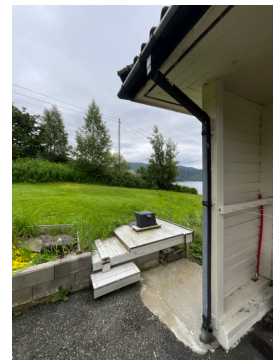
Nedløp ført under bakkenivå, langsida nordøst.
