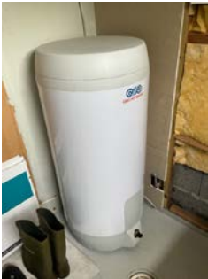
Varmtvannstank montert på vaskerom.
