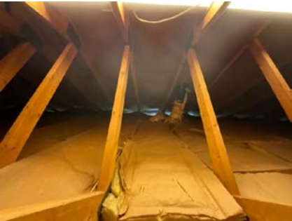
Synlig lufting i raft/ kiste.
