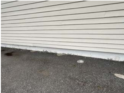
Lufteluker i vegger.
