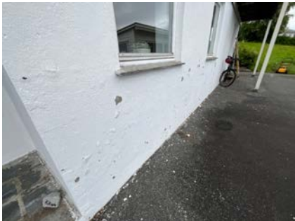
Grunnmur ved hovedinngang
