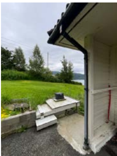
Nedløp ført under bakkenivå, langs side nordøst.
