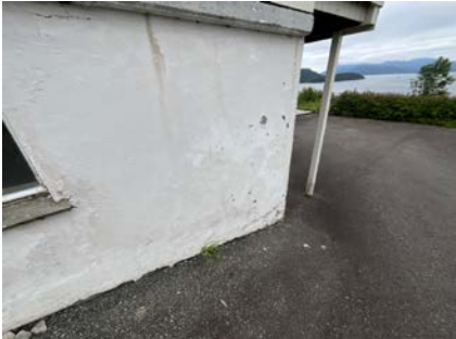
Grunnmur garasje under terrasse.
