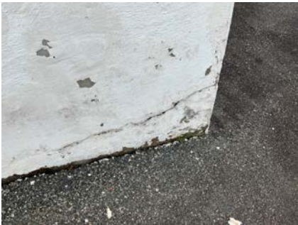
Nærbilde av grunnmur garasje under terrasse.
