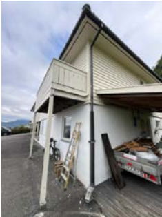
Nedløp ført under bakkenivå, langs side nordøst.
