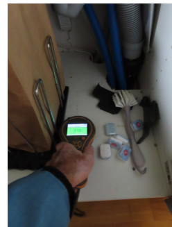
Fuktsøk i benkeskap - ingen påviste forhøyede fuktverdier.
