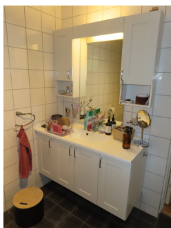
Del av dusjbad - servantskap med helstøpt servantplate.
