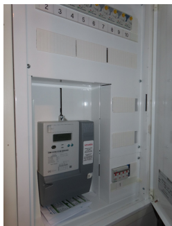
Sikringsskap med jordfeilautomater og 400 volts inntakssikring.
