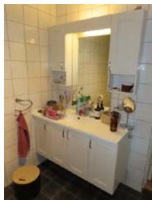
Del av dusjbad - servantskap med helstøpt servantplate.
