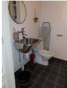
Vaskerom/toalettrom, kombinert rom med tekniske installasjoner.
