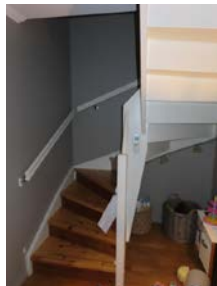
Intertrapp mellom 1 og 2.etg.
