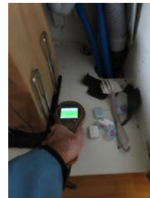
Fuktsøk i benkeskap - ingen påviste forhøyede fuktverdier.
