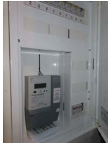
Sikringsskap med jordfeilautomater og 400 volts inntakssikring.
