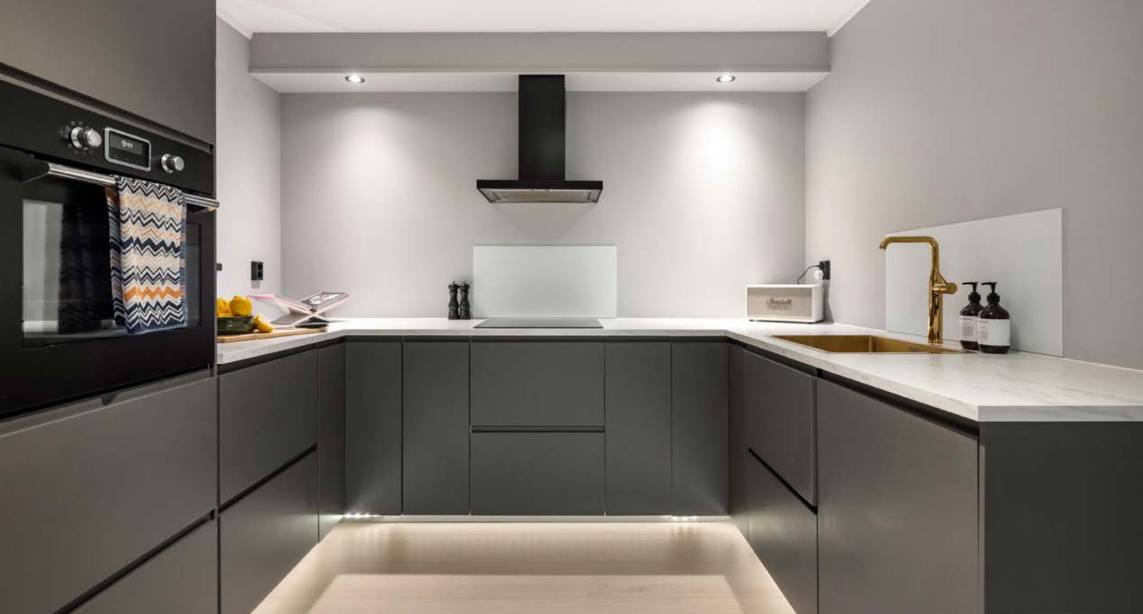
Praktisk med glassplater i benkeryggen ved platetoppen og oppvaskkummen. Over platetoppen er det mekanisk avtrekksvifte og innfelte downlights i kasse.
