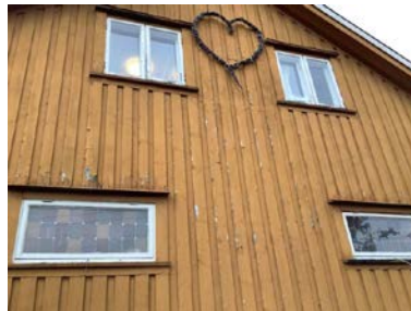
Værslitt bordkledning.
