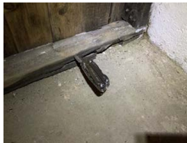
Råteskadet delevegg.
