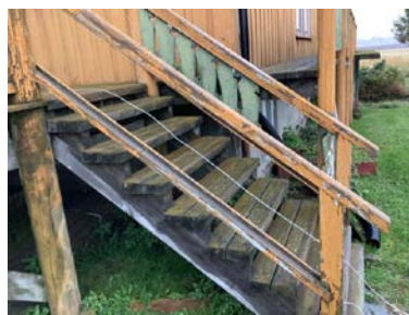
Rekkverksbord mangler.
