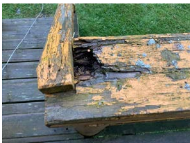
Råteskadet håndløper.
