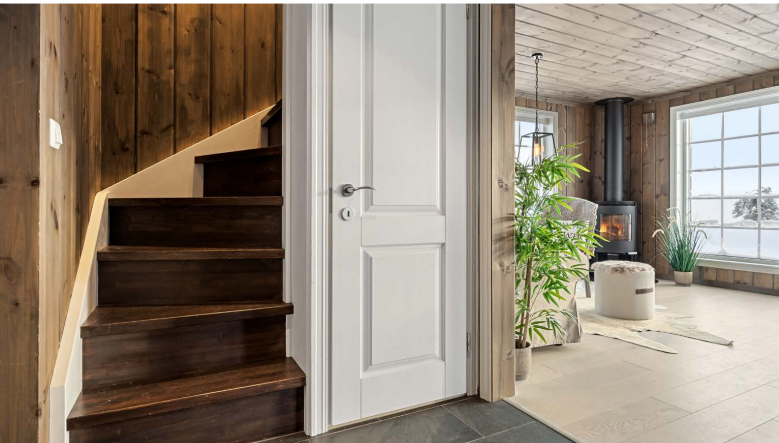
Bod under trapp med varmtvannsbereder. Det er montert lekkasjestopper.
