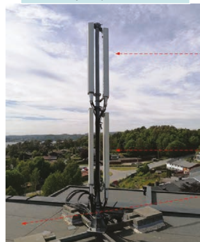
Eksisterende gravitasjonsfeste sett fra taket.
