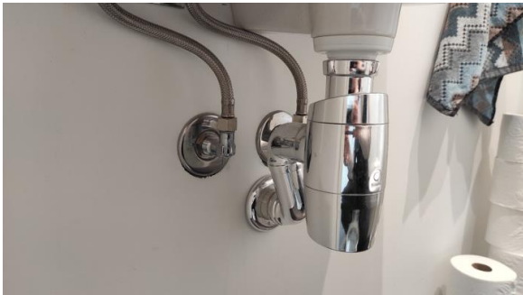
Kontroll av røropplegget.
