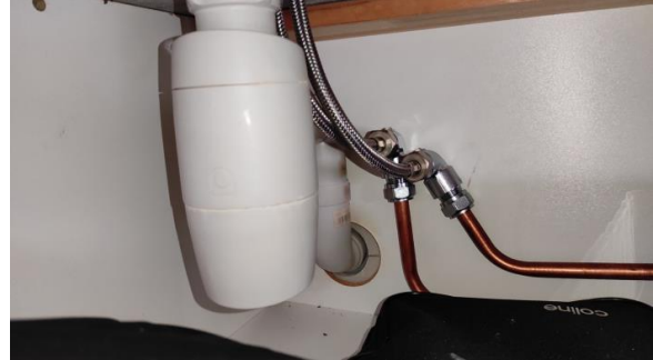
Kontroll av røropplegget.
