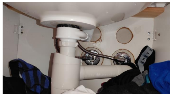
Kontroll av røropplegget.
