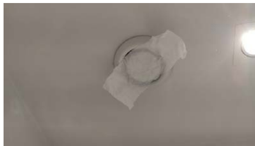
Funksjonstest av avtrekket.
