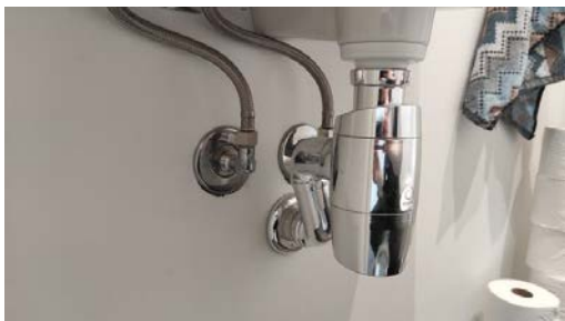
Kontroll av røropplegget.
