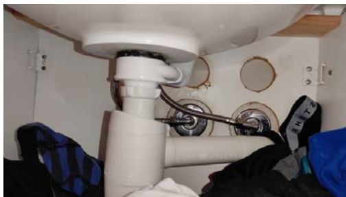
Kontroll av røropplegget.
