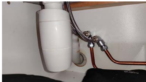
Kontroll av røropplegget.
