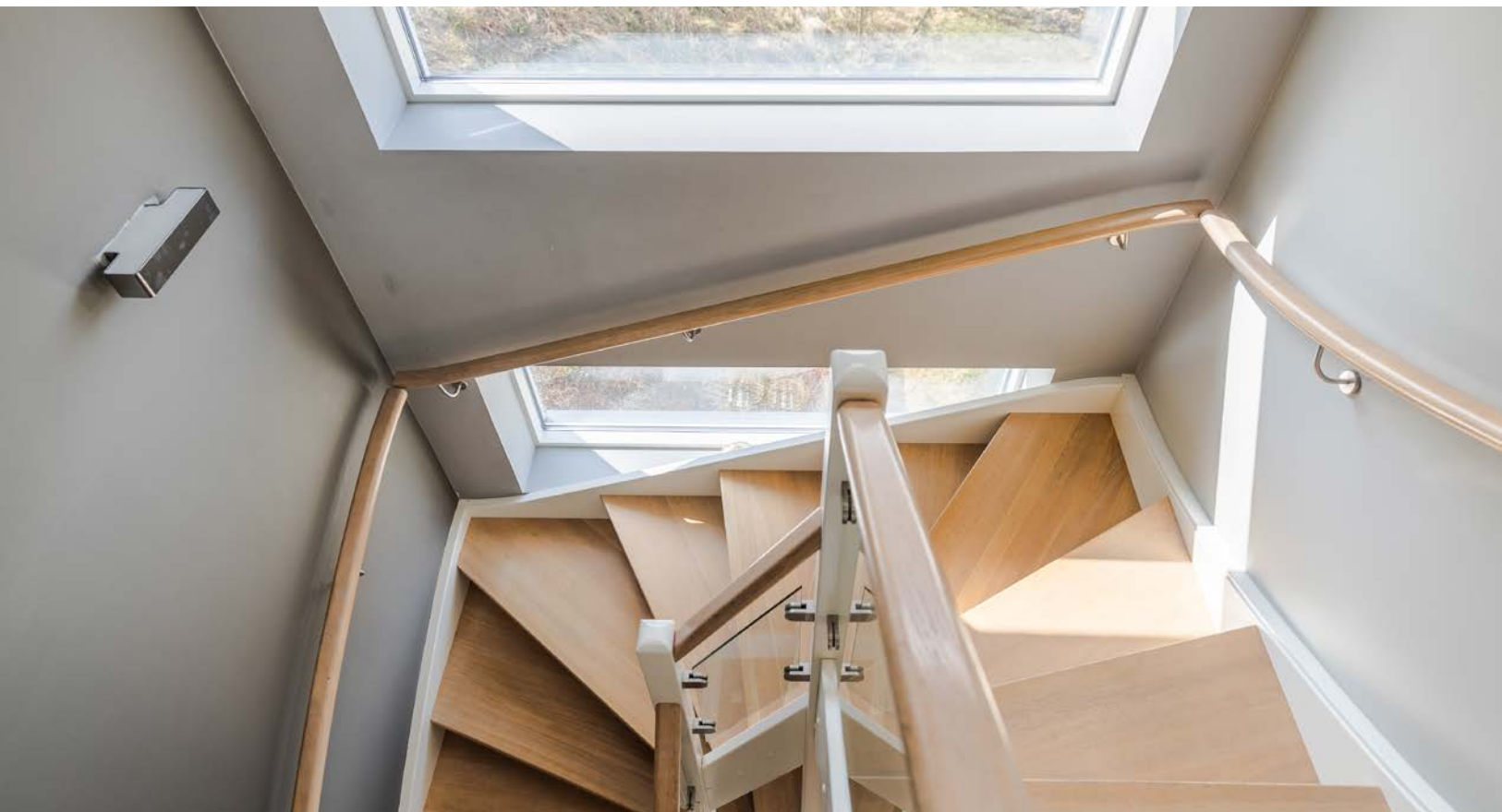
Malt tretrapp som strekker seg fra sokkeetasjen til 2. etasjen. Inntrinn er tekket med lakkert eik.
