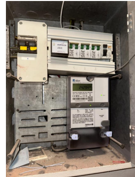
Sikringskap med automatsikringer.
