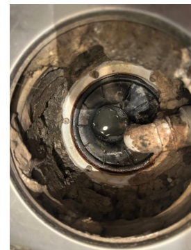
Plastsluk med klemring for membran
