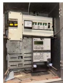
Sikringsskap med automatsikringer.
