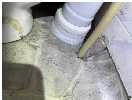
Eksempel på utettheter på vinylbelegget.
