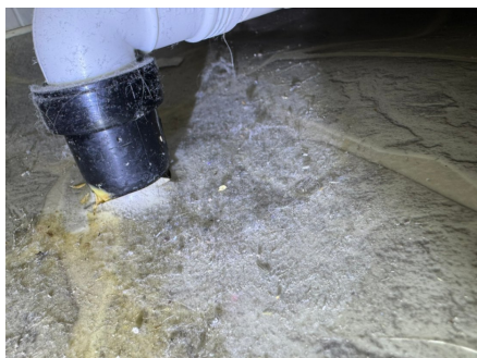
Eksempel på utettheter på vinylbelegget.
