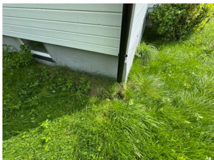
Eksempel på takrennenedløp som er avsluttet over bakken.
