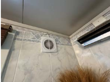
Mekanisk avtrekk på badet.
