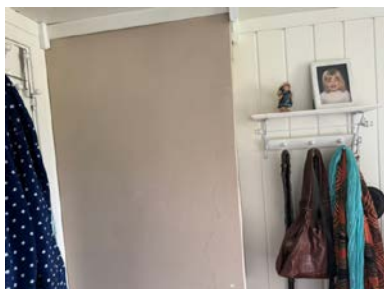
Eksempel på riss i pipen.
