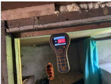
Fuktmåling i kjelleren.
