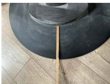
Ildfast plate under ovnen er ikke stor nokk.
