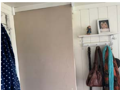
Eksempel på riss i pipen.
