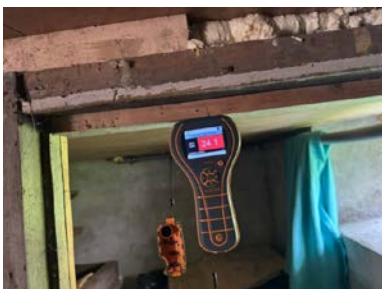
Fuktmåling i kjelleren.
