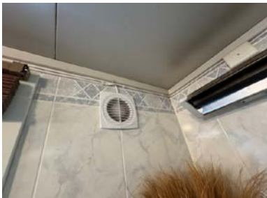
Mekanisk avtrekk på badet.
