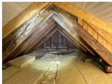
Konstruksjonen er begrenset ventilert.
