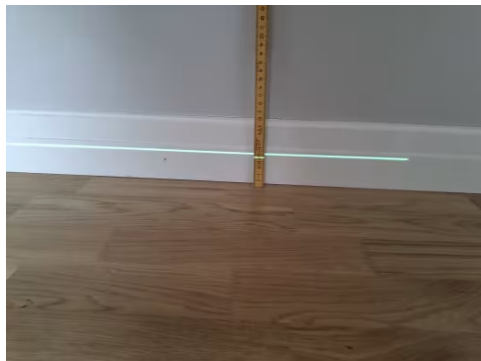
Etasjeskillet er kontrollert med nivelleringslaser.
