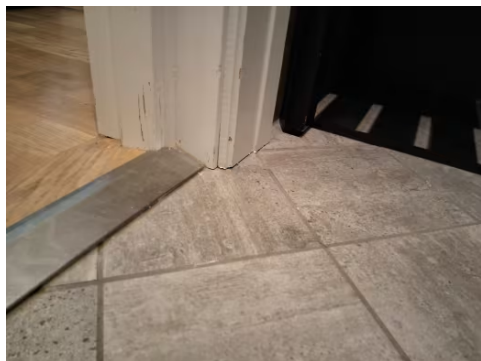
Det kan ikke verifiseres at det er etablert en oppkant på
