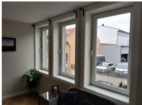
Leiligheten har vinduer med plastkarmen og tre-lags glass.
