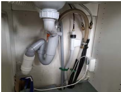
Leiligheten har synlige avløpsrør av plast.
