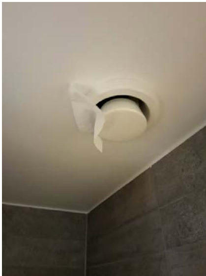
Avtrekkseffekt er testet med papir.
