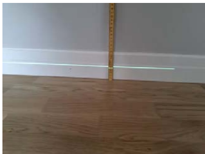
Etasjeskillet er kontrollert med nivelleringslaser.
