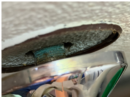
Utett rørgjennomføring.
