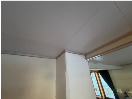
Pipe mot vest har fyringsforbud.
