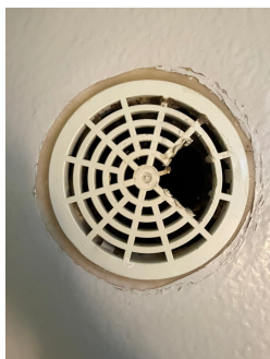
Slukristen er fuget fast i gulvbelegget.
