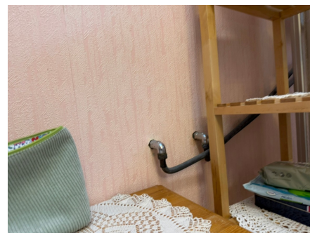
Utett rørgjennomføringer.
