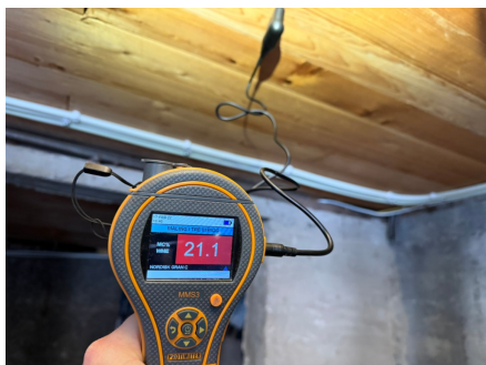
Fuktmåling i etasjeskillet mot kjelleren.
