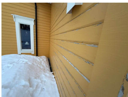
Tynslitt overflatebehandling.
