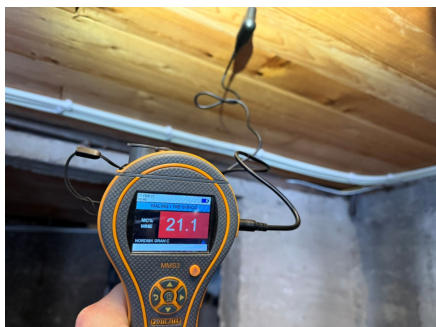
Fuktmåling i etasjeskillet mot kjelleren.
