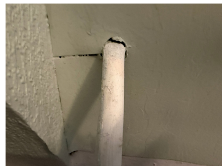
Uttett gjennomføring i vegg.
