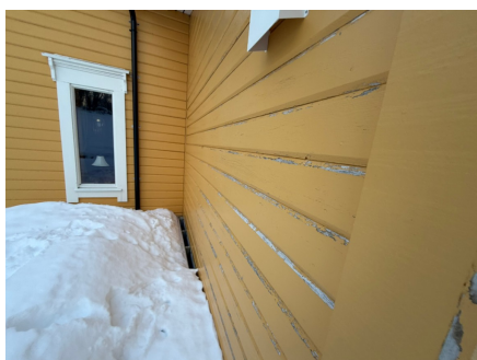
Tynslitt overflatebehandling.
