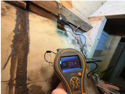
Fuktmåling ved pipe.
