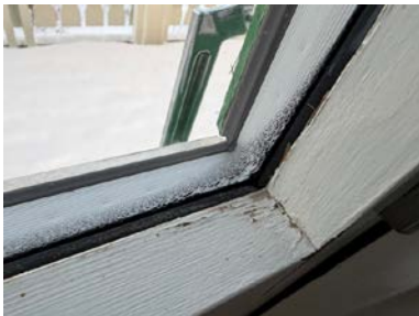
Kondensering på innvendig glass.
