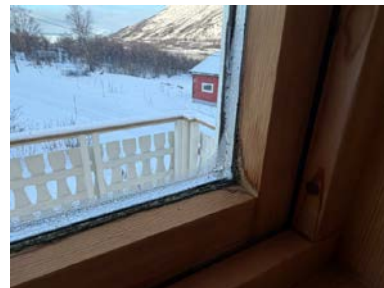
Eksempel på kondensering på innvendig vindusglass.
