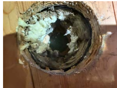
Åpning i etasjeskillet.
