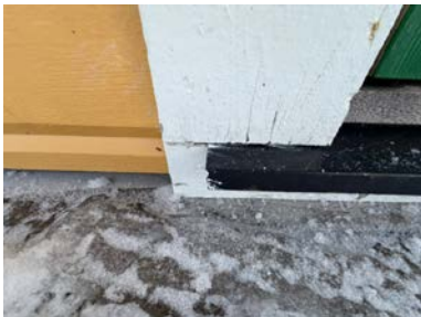
Eksempel på omramming som støter mot vannbrettbeslag.
