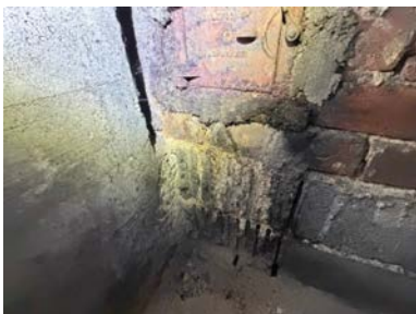
Sotluken lot seg ikke åpne på befaringstidspunktet.
