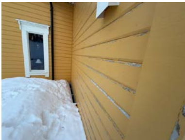
Tynslitt overflatebehandling.
