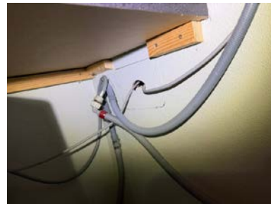
Utett gjennomføring i vegg.
