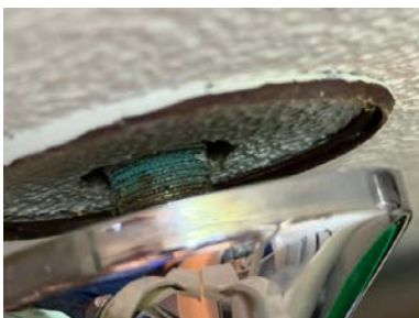
Utett rørgjennomføring.
