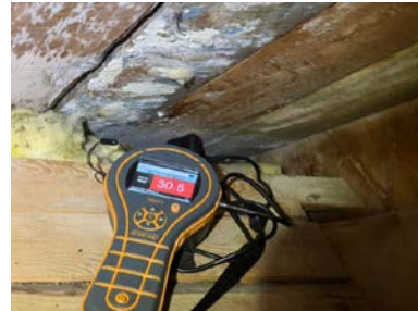
Fuktmåling i undertak.
