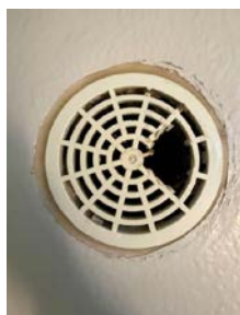
Slukristen er fuget fast i gulvbelegget.
