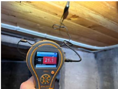
Fuktmåling i etasjeskillet mot kjelleren.
