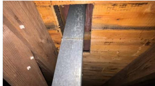
Synlig eternitt-tekking i gjennomføringer
