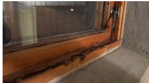
Eldre vinduer i kjelleren
