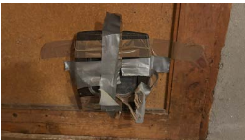
Katteluke på kjellerdøren
