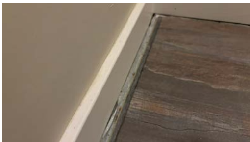
Gulvlisten dekker ikke gulvet i entreen
