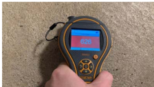
Utslag på forhøyde fuktverdier på gulvet i kjelleren
