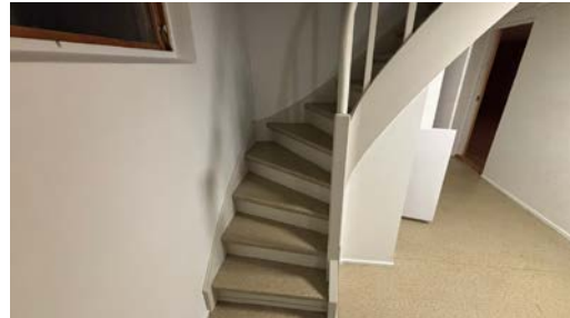
Oversiktsbilde av trappen
