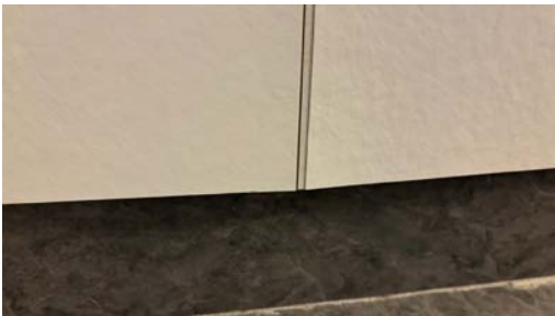
Skjøtene på baderomsplatene har mindre åpninger og er montert uten sokkelprofil
